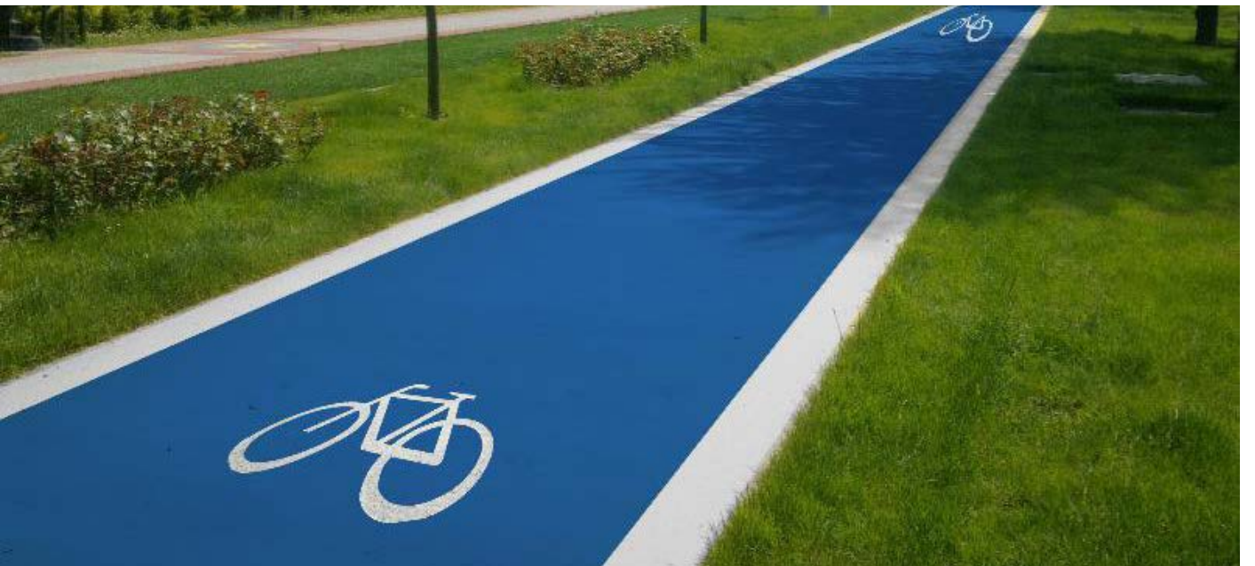
SU BAZLI EPOKSİ BETON VE ASFALT KAPLAMA VE BOYAMA
